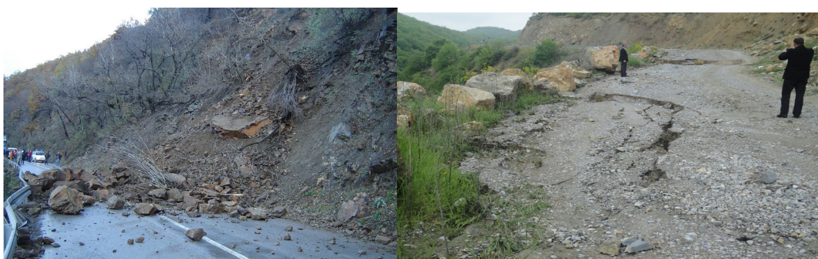
Foto 5 Rrëshqitjet e dheut në nacionalen N2 dhe lokalen HiE-Gllloboçicë/ Kaçanik (PZHK HiE 2010-2025)
